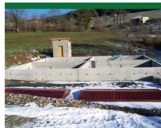
« biologique » suivi d'un lit planté de roseaux. Cette technique utilise le principe de l'épuration par culture fixée sur 2 étages, le premier étage est constitué de biodisques qui permettent de traiter au maximum la pollution carbonée et azotée et le second étage est constitué d'un dispositif de filtration et permet ainsi le stockage des boues. (Cette technique permet aussi de traiter le phosphore).
